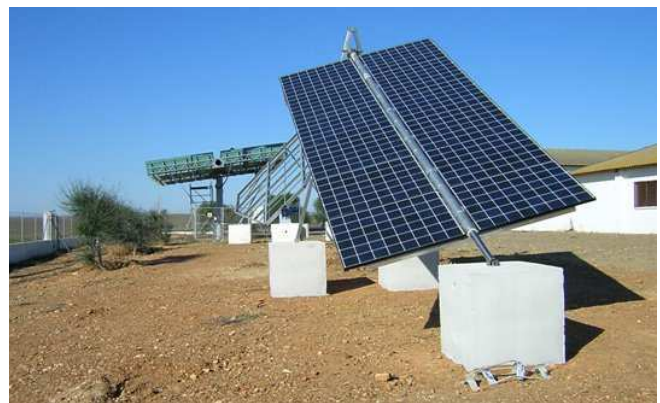
Obr. 2. Jednoosí tracker s orientáciou sever-juh.
