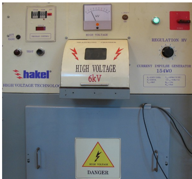
Obr. 3. Generátor impulzov prúdu; nabíjacie napätie na kondenzátorovej batérii nastavené na 1,9 kV.
