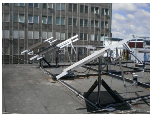
Obr. 4. Inštalácia fotovoltaických panelov pomocou polohovacieho zariadenia – trackera
