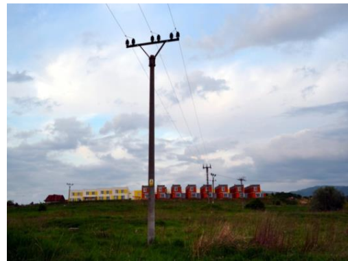
Obr. 13 Vedenie 22 kV
