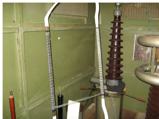
Obr. 9 Meranie cievky bez polovodivej ochrany 6 kV asynchrónneho motora s celkovým pokrytím vynutia
