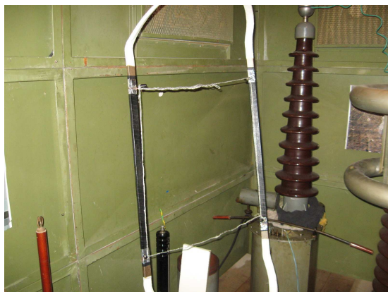
Obr. 8 Meranie cievky bez polovodivej ochrany 6 kV asynchrónneho motora metódou štyroch bodov uzemnenia
